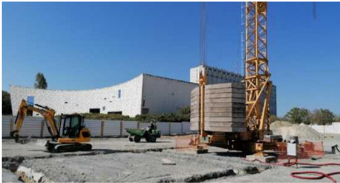
Le chantier du futur bâtiment Olga-de-Saint-Affrique a démarré en mars. F. Z.
